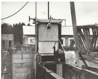
Рис. 2. Выпускное устройство-затвор
